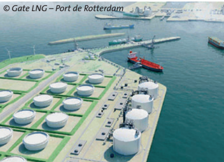
© Gate LNG – Port de Rotterdam
