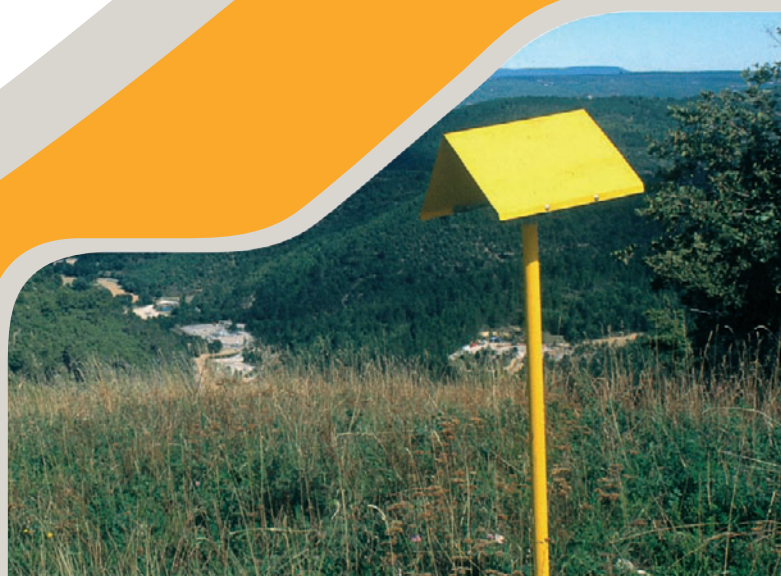
Balise jaune, signe de la présence d'une canalisation
